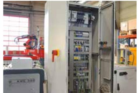
Die Anlage verfügt über eine eigene Energieverteilung für alle benötigten Komponenten.
