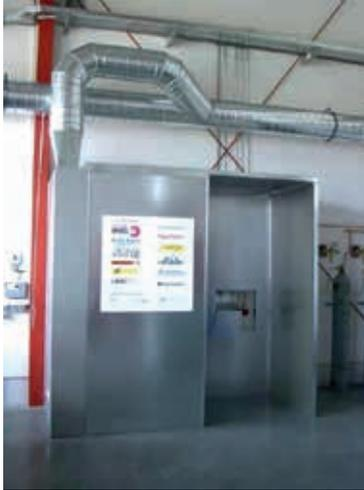
*Schleifkabine mit angeschlossener Absaugleitung im Technologiezentrum*
